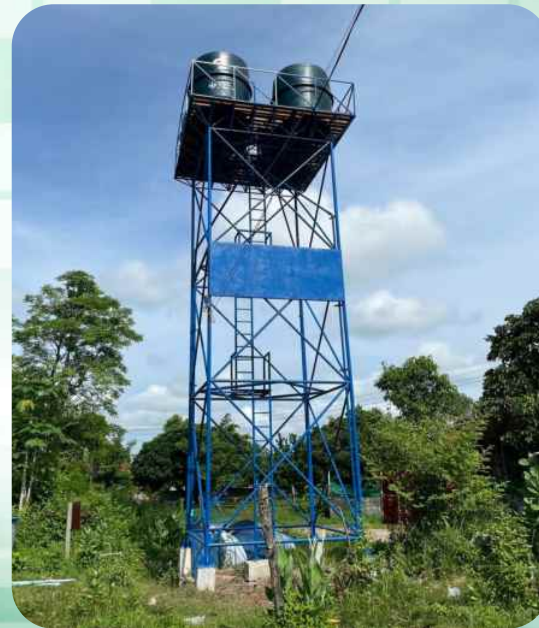
ดำเนินการแล้วเสร็จ
